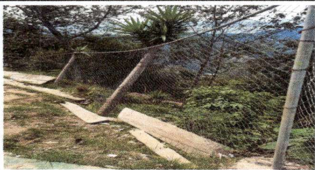
Foto 7: Reparacion de muro de contención
