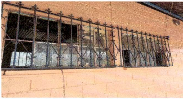
Foto 1: Sustitucion de vidrios
