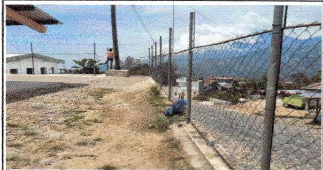
Foto 4: Reparación de planchas de concreto, de patio
