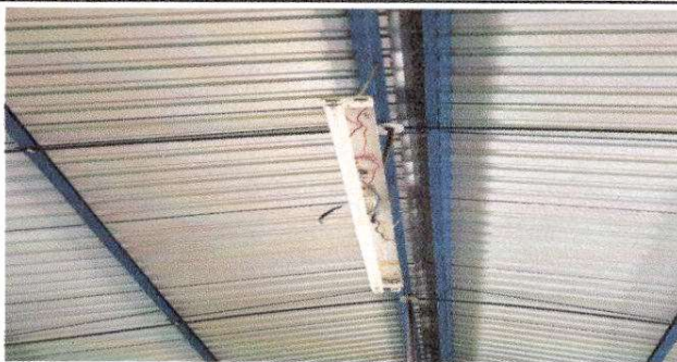
Foto 5: Sustitución de focos ahorradores + Reparación de cableado eléctrico
